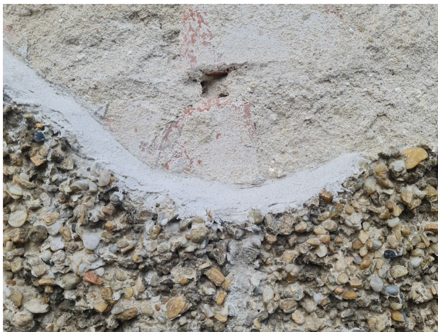
Fig. 5. București, casă pe str. Mătăsari nr. 41 (1937): tencuială cu pietriș de râu. Tivire și consolidare cu mortare prefabricate pe bază de var la tencuiala parțial desprinsă, pentru a-i opri degradarea (Foto: M. Moldovan 2023).
