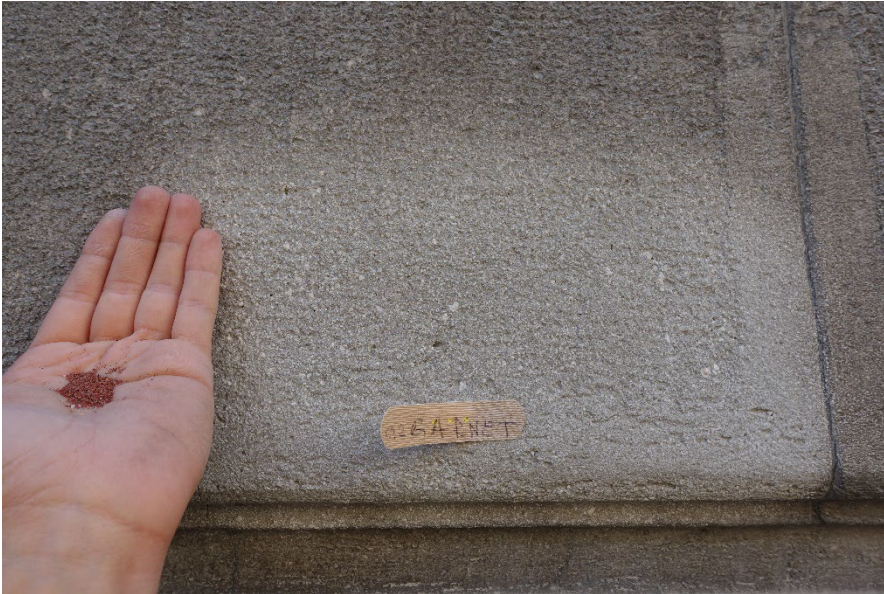
Fig. 3. București, Palatul Universității (corpul din perioada interbelică): suprafață curățată prin sablare (test), rezultând o estompare a texturilor originare realizate prin buciardare (Foto: M. Moldovan 2023).
