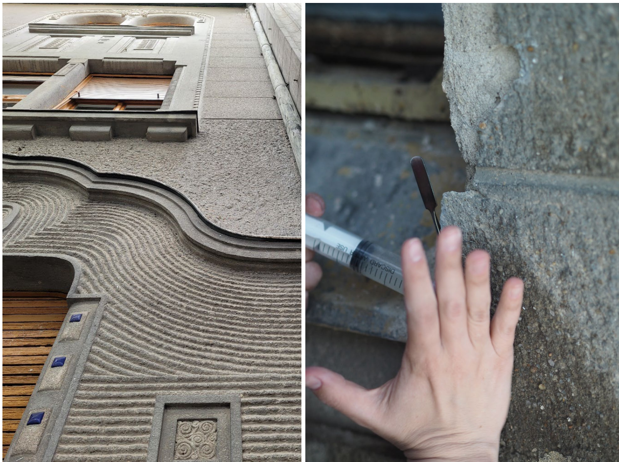
Fig. 1. Timișoara, Palatul Dauerbach (1911-1912): fațada din similipiatră cu diferite texturi și rugozități; injectare cu apă alcoolizată între stratul de bază și similipiatră, ca parte a procesului de consolidare (Foto: M. Moldovan și R. Sacaliș, 2023).
