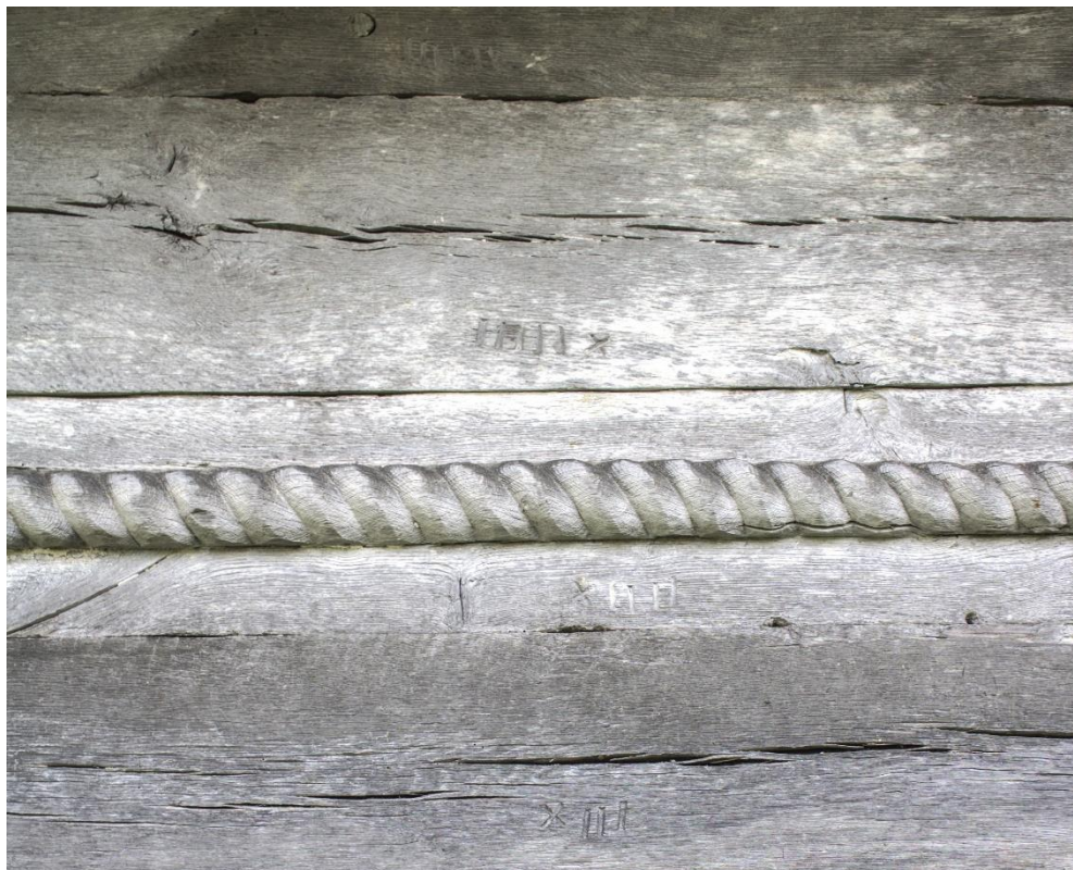
Fig. 9. Biserica din Bozna - semne dulgherești, de jos în sus: XIII , XIII , IIIX (ultimul poziționat invers).
