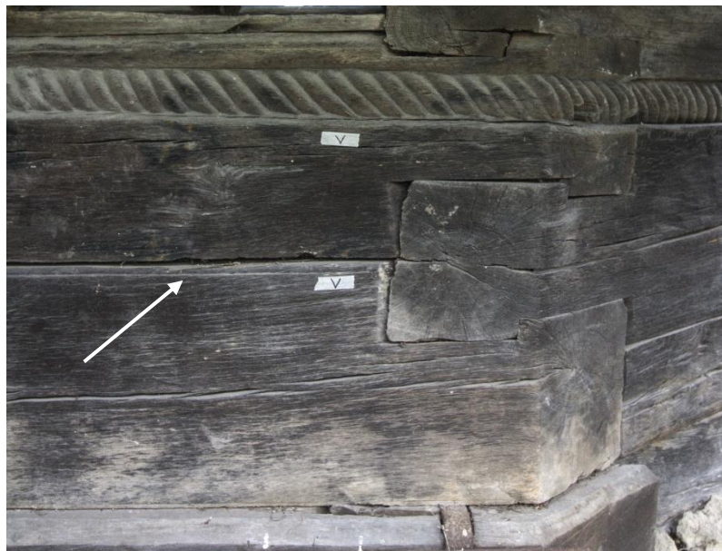
Fig. 4. Detaliu de la Buzaș / Săliștea Nouă cu bârnă având marginea profilată.
