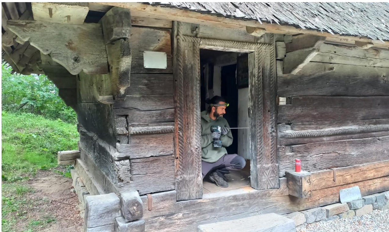
Fig. 7. Biserica de lemn din Doba - prelevarea de probe. În imagine, se pot observa tălpile înnoite ale bisericii.
