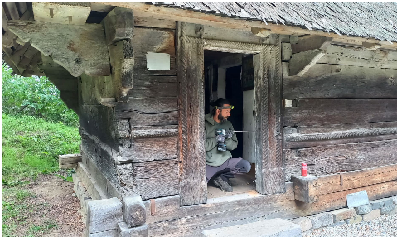
Fig. 7. Biserica de lemn din Doba - prelevarea de probe. În imagine, se pot observa tâlpile înnoite ale bisericii.
