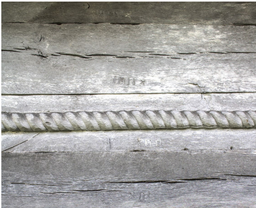
Fig. 9. Biserica din Bozna - semne dulgherești, de jos în sus: XIII, XIII, IIIIX (ultimul poziționat invers).
