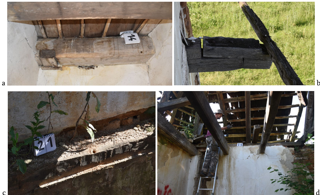
Fig. 10. a, c-d: probele 14, 21 și 25 (grupa 1s); b. consola galeriei exterioare încastrată în zidărie și care se îmbină la interior cu grinda probei 14 (Anno Domini Dendrolab, 2023).
