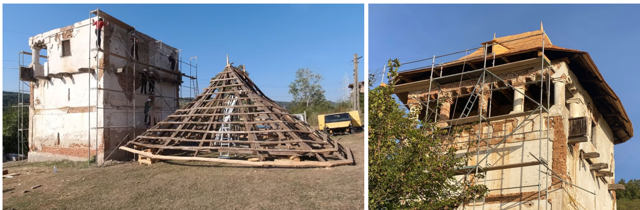
Fig. 13. Cula Crăsnaru în timpul și la finalul intervenției de refacere a acoperișului (Eugen Vaida, 2023).
