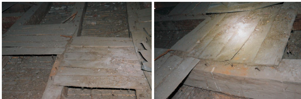
Fig. 15. Scânduri de stejar din planșeul podului (Anno Domini Dendrolab, 2017).
